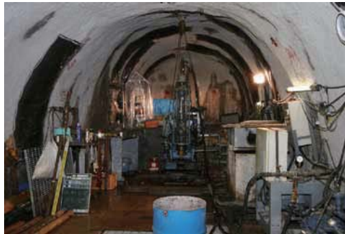
深度300mボーリング横坑での 水圧観測用ボーリング孔の掘削
